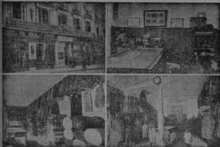
Cuatro vistas parciales de la Casa Matriz en Granada, calle de Reyes Católicos
